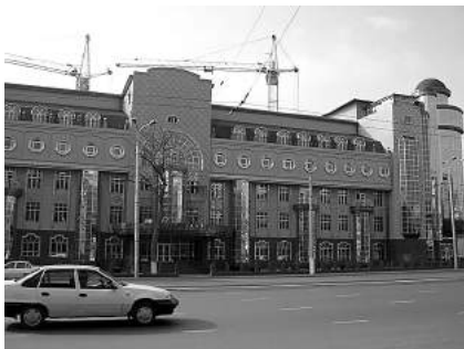
Ил. 10. Строящийся отель и бизнес-центр, ул. Шахрисабз. Фото автора
