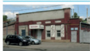
14 Перестроенное здание «Мещанской синагоги». Ул. Гражданская, 19. Фото 2009 г. The reconstructed building of “Meshchanskaya” prayer house/synagogue. 19 Grahdanskaya St. Photo made in 2009.
